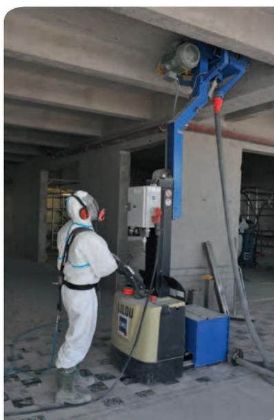
*Raboteuse avec aspiration centralisée*
