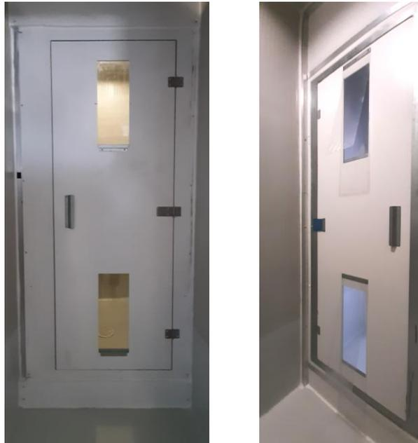
**Figure 13 : Porte d'entrée rigide avec deux ouvertures et déflecteurs sur le sas d'entrée extérieur.**
